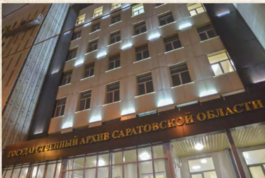
Новое здание для ГАСО
