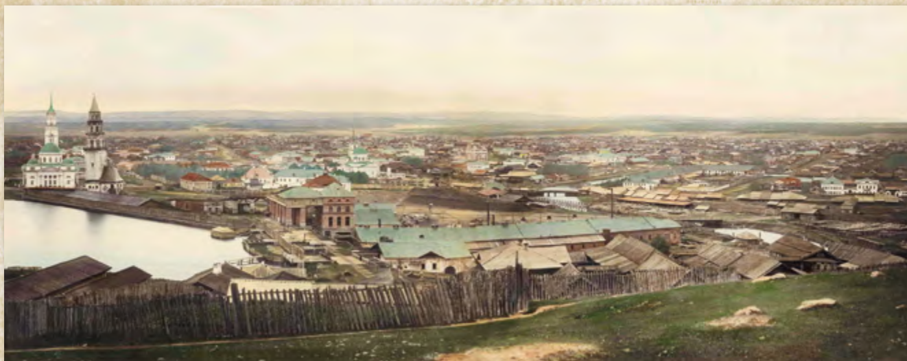
Вид Невьянского завода с горы Лебяжки.
